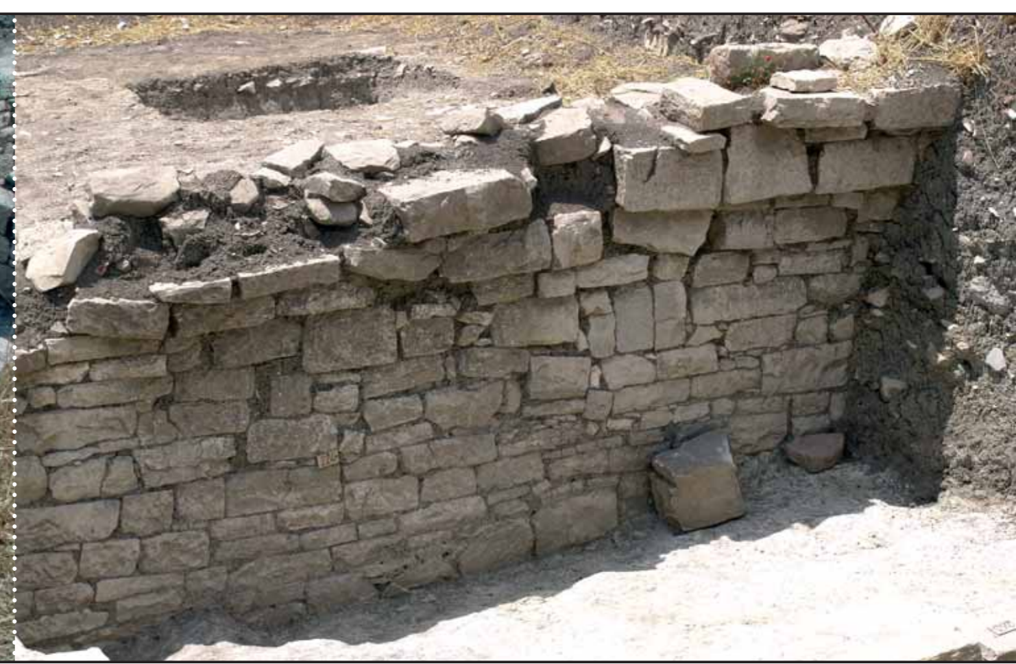
muro di contenimento dell'ambulacro (lato nord)
