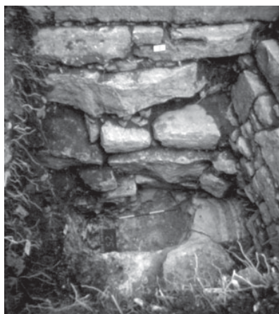
1. Erice (1999). Saggio 2. Fondazioni della torre N a fine scavo.
