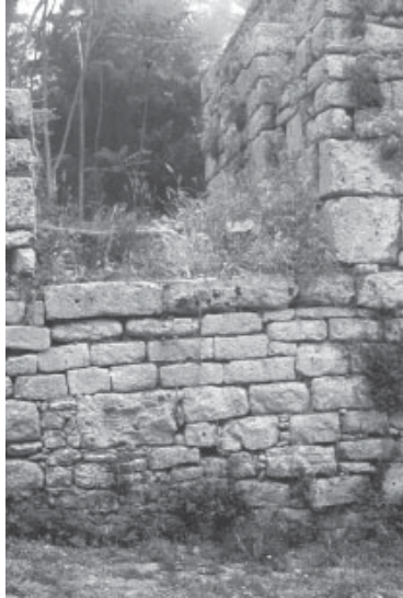
3. Erice (TP). Cinta muraria: torre M (a sinistra) e 'postierla' 3, dall'interno.
