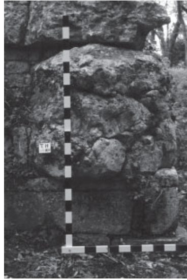
2. Erice (TP). Cinta muraria: torre H, lato NO, angolo N.
