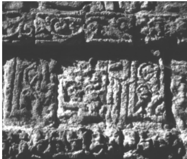
2. Cefalà Diana (PA). Edificio termale, Lato N. Particolare della fascia epigrafica.
