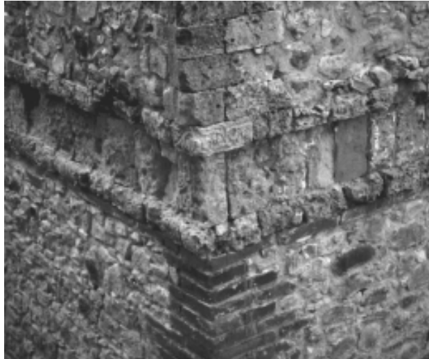
1. Cefalà Diana (PA). Edificio termale, esterno. Particolare dell'angolo NO. Notare le diverse tecniche murarie per la realizzazione dei paramenti e dei cantonali nelle parti poste al di sopra e al di sotto della fascia epigrafica.
